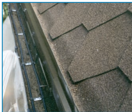
Рис. 8 Пример укладки нагревательных секций в лоток
