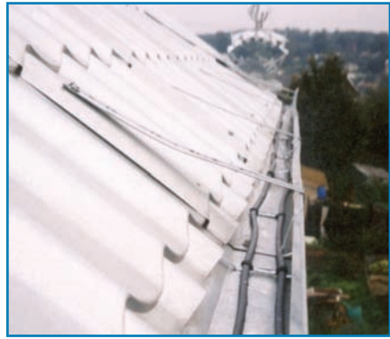
Рис. 12 Пример укладки нагревательных секций в укрепленный лоток
