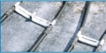
Рис. 4 Пример установки металлических зажимов
