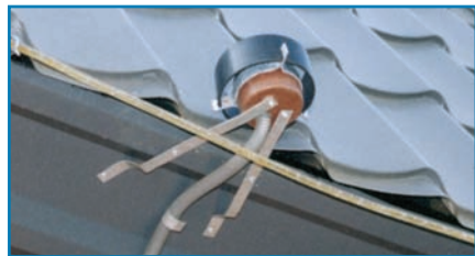
Рис. 26 Пример установки датчика осадков на скате кровли
