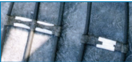
Рис. 5 Пример установки металлических зажимов (изоляцией обмотаны зажимы)
