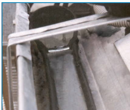
Рис. 7 Пример укладки нагревательных секций в лоток (хорошо виден зажим)
